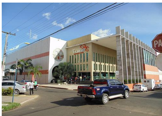
Foto 1: Imperatriz- MA. Vista parcial do Tocantins shopping center.
