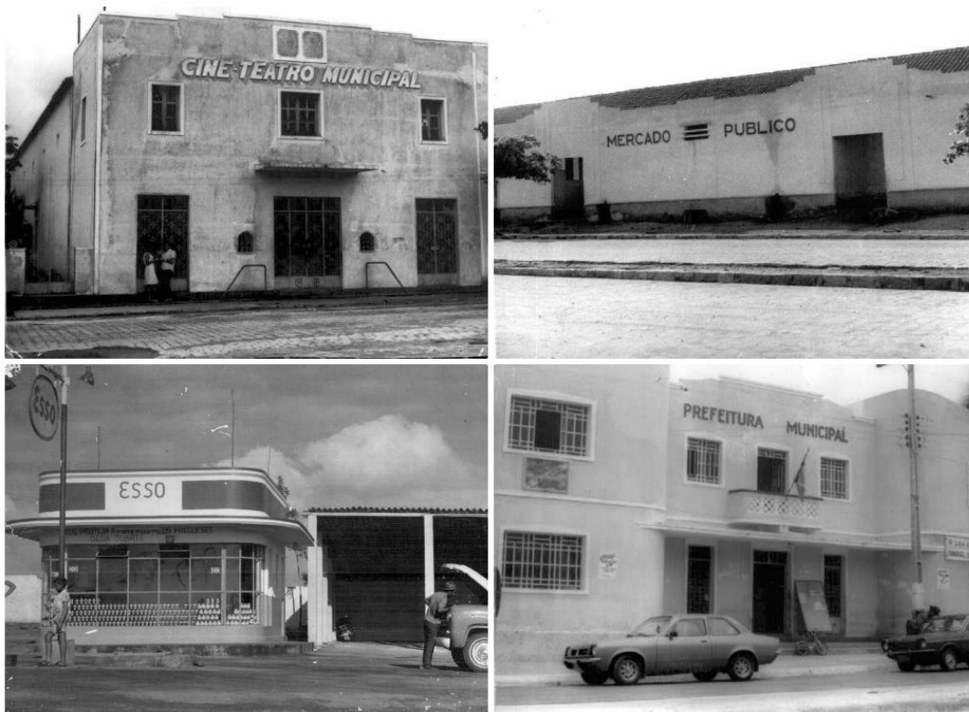
Figura 3: Registros das primeiras construções da Av. 1º de abril.
